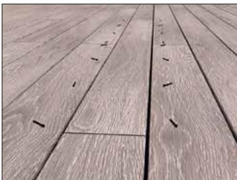
Kruvide eemaldamine
