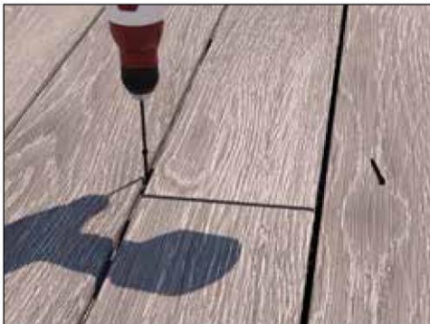
Kruvide eemaldamine
