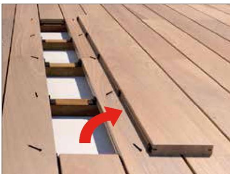
Laua eemaldamine
